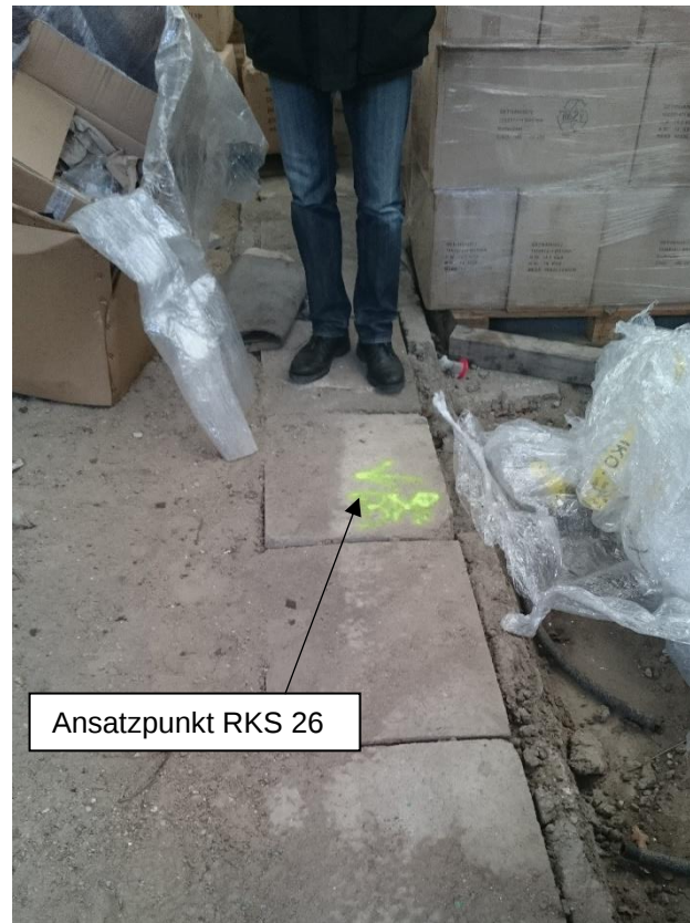
Bild 3: Abgedeckte Gruben/Gräben in der Halle (RKS 26)
