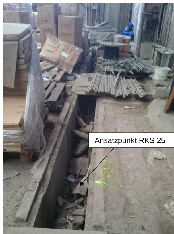
Bild 2: Gruben/Gräben ehem. Hydraulik-Leitungen in der Halle (RKS 25)
