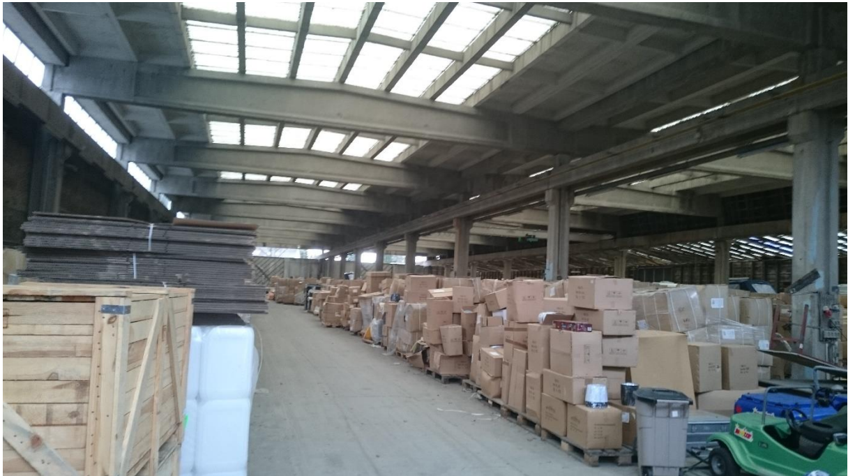
Bild 1: Ehem. Fertigungshalle; Blickrichtung Norden
