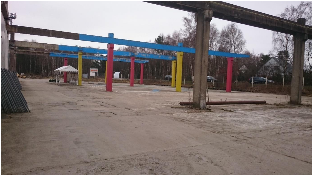
Bild 1: Bereich zwischen Fabrikhalle und Schleswig-Holstein-Straße; Blickrichtung Osten
